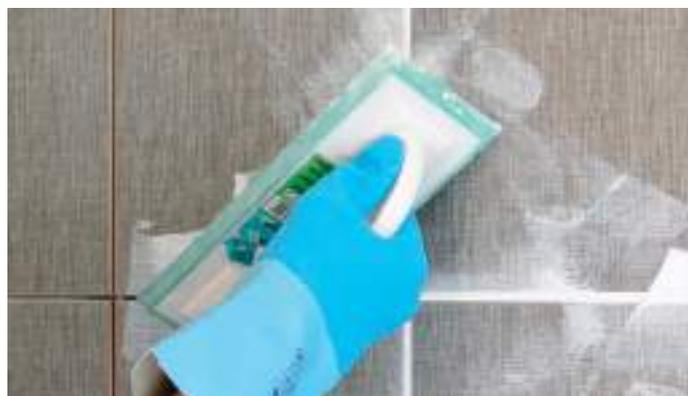
Remplissage des joints en diagonale à l'aide d'une taloche caoutchouc
